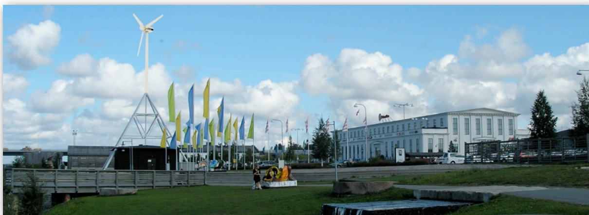
Figur B4.4. Fotomontage. Horisontellt vindkraftverk, Aeolos 10 kW med 10 meters torn, från Aeolos wind turbine.
