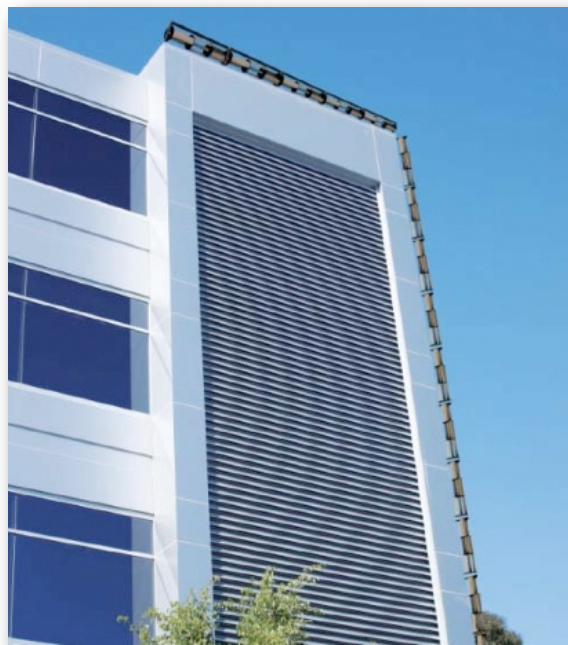
Figur 10. Windpods placerad längs väggen och taket på en byggnad. [21]
