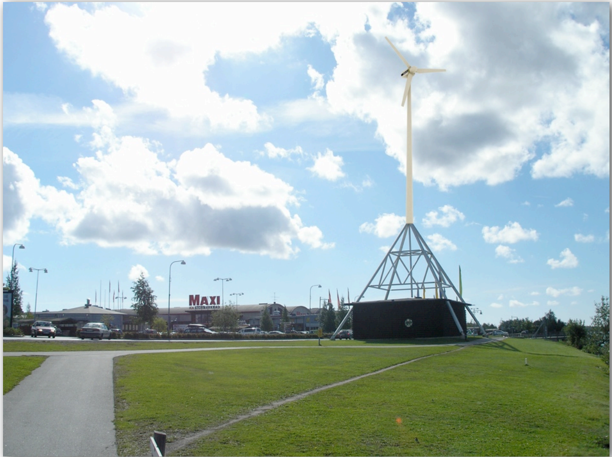
Figur B4.5. Fotomontage. Horisontellt vindkraftverk, Aeolos 10 kW med 18 meters torn, från Aeolos wind turbine.
